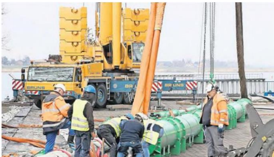
Die neue XXL-Abwasserleitung wurde am Mittwoch am Elbufer bei Geesthacht am abgeschalteten Atomkraftwerk Krümmel montiert.
